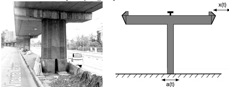
Cuando la estructura es solicitada por un terremoto, el movimiento horizontal  $x(t)$  de la parte superior de ésta queda modelado por la siguiente ecuación diferencial:
